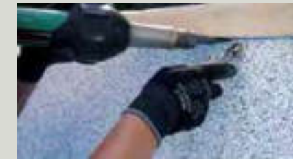
5. Wände mit RENOLIT ALKORPLAN TOUCH auskleiden.
