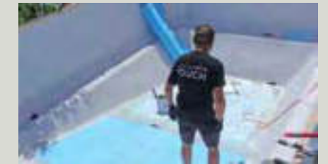
6. Boden stumpf oder überlappend verlegen.
