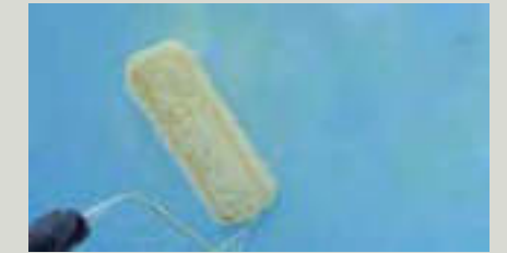
3. RENOLIT ALKORGLUE Kontaktkleber vollflächig auftragen.
